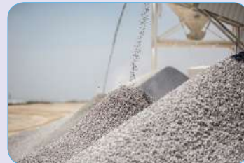
Fig.a : concassage des roches massives.
