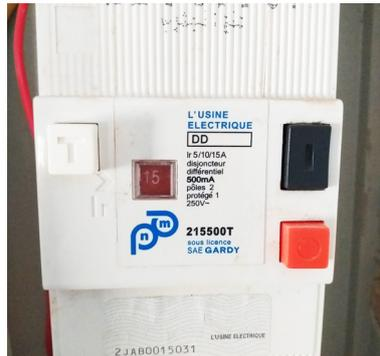
Fig.b Le disjoncteur différentiel
